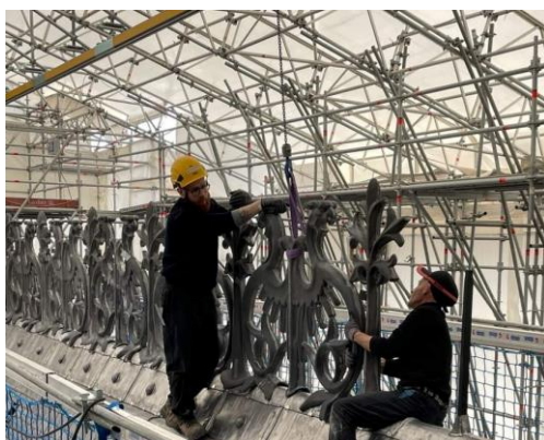
Pose d'éléments de faitage après restauration © S.Leleu/Centre des monuments nationaux
