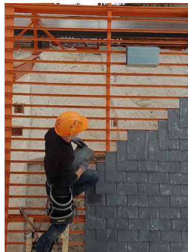
Pose d'ardoises sur la charpente métallique – © S.Leleu/Centre des monuments nationaux
